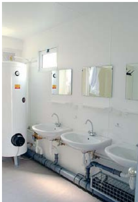
Sanitär-Container mit Baustellenausführung
